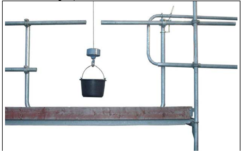
Fig. 6 Sicherung der Be- und Entladestelle
